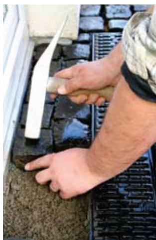
Пример монтажа канала в брусчатке
