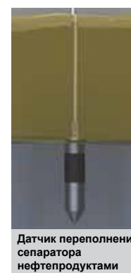
Датчик переполнения сепаратора нефтепродуктами
