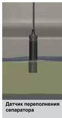
Датчик переполнения сепаратора
